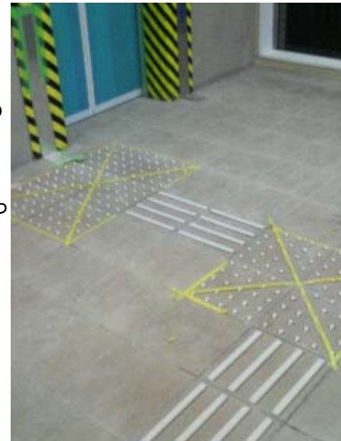
⑤完成・養生
