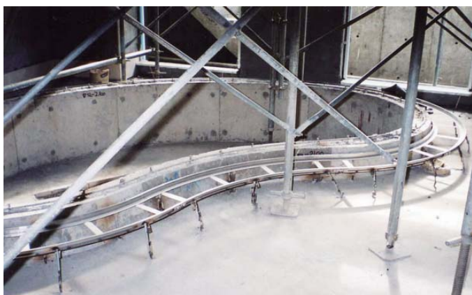
現地施工によってアンカー部分を溶接固定する事で枠の高さレベルの調整をおこないます。
